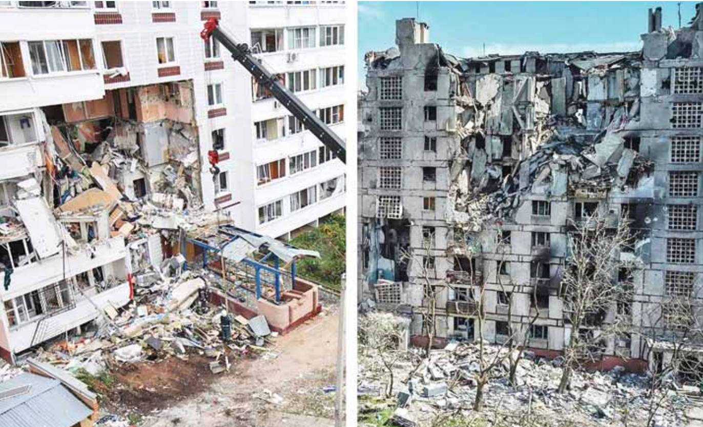
Рис. 2. Разрушение зданий вследствие техногенных воздействий Fig. 2. Destruction of buildings due to man-made impacts
