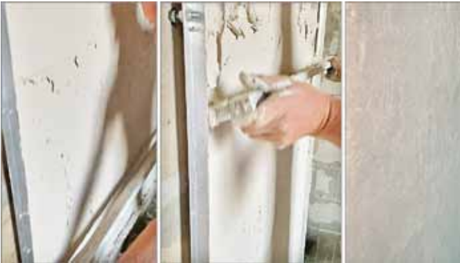
Рис. 2. Нанесение, разравнивание раствора правилом и готовая под окончательную отделку оштукатуренная поверхность перегородки с использованием предложенной технологической оснастки – штукатурной рамки Fig. 2. Application, leveling of the mortar according to the rule and the plastered surface of the partition ready for final finishing using the proposed technological equipment - a plaster frame
