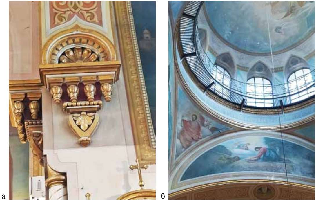
Рис. 1. Казанский собор в г. Феодосии: а) выше 2 метров от уровня пола стены покрыты копотью, сажей и продуктами горения свечей и лампад; б) отслоение, шелушение, растрескивание живописного слоя на парусах, сводах и куполе собора Fig. 1. Kazan Cathedral in Feodosiya: a) soiling and deposits of combustion products from candles and icon lamps on walls above 2 meters from floor level; b) delamination, flaking, and cracking of the painted layer on the sails, vaults, and dome of the cathedral
