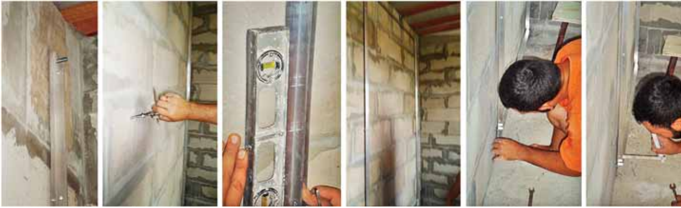
Рис. 1. Монтаж инновационной оснастки и проверка её положения Fig. 1. Installation of innovative equipment and checking its position
