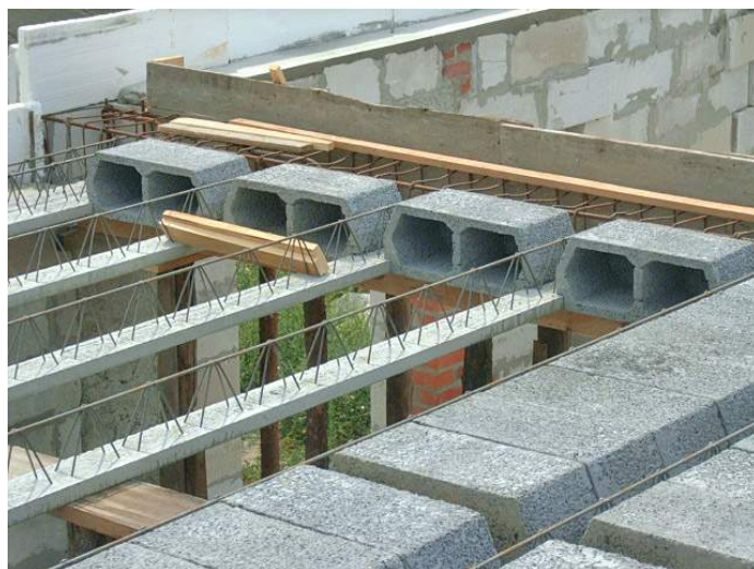
Рис. 6 Конструкции СМП Porotherm
