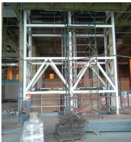
Рисунок 1. Лифтовые шахты до остекления Figure 1. Elevator shafts before glazing
