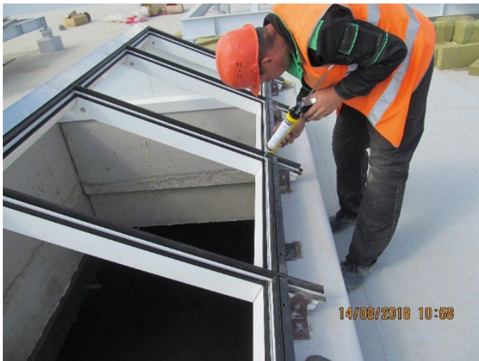
Рисунок 7. Процесс монтажа двускатных зенитных фонарей
