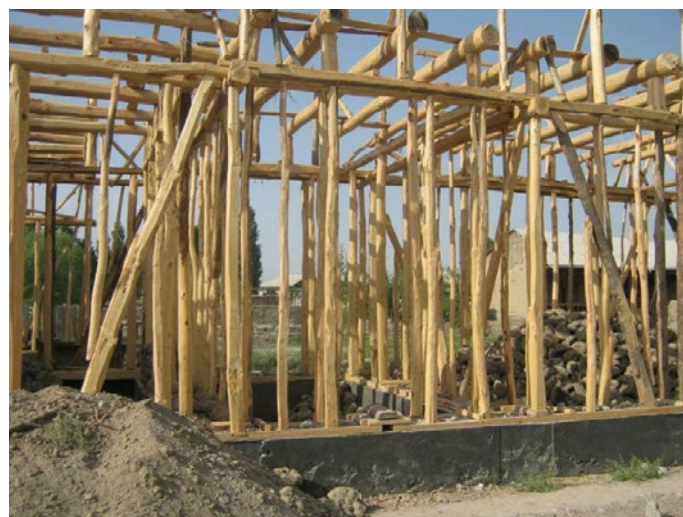
Рис. 5 Общие виды смоделированных систем по вариантам задачи: а) при исследовании необходимости устройства анкерных связей для соединения нижних обвязочных брусов синчевых каркасов с фундаментами; б) при исследовании решения синчевого каркаса с использованием в его верхней части шарнирно-подвижной стоечно-балочной системы
