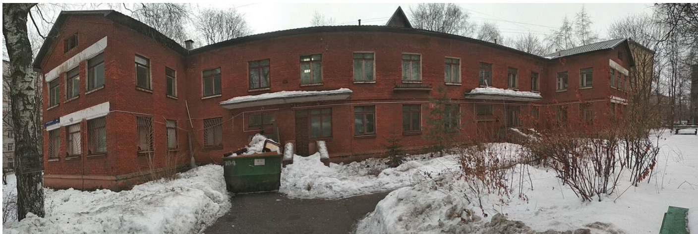
Рисунок 1. Общий вид объекта, Москва, ул. Добролюбова, 20А. Объект А. Figure 1. General view of the object, Moscow, ul. Dobrolyubova, 20A. Object A.
