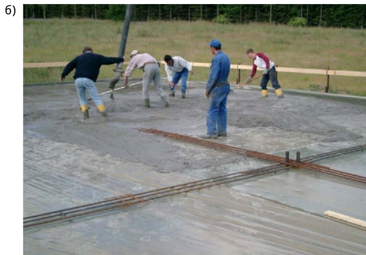
Рис. 4. а) Фибробетонная смесь; б) возведение прототипа. Figure 4. a) SFRC b) Construction of the SFRC prototype
