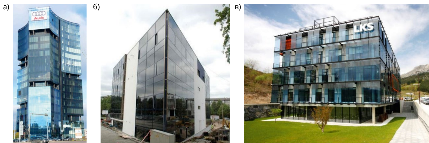
Рис. 8. Здания с использованием сталефибробетона в монолитных перекрытиях: а) 16-этажное здание в Таллине, б) треугольное здание в Таллине, в) офисное здание в Испании. Figure 8. Buildings with SFRC flat slabs: a) 16 floor building in Tallinn b) Triangle building in Tallinn c) Office building in Spain
