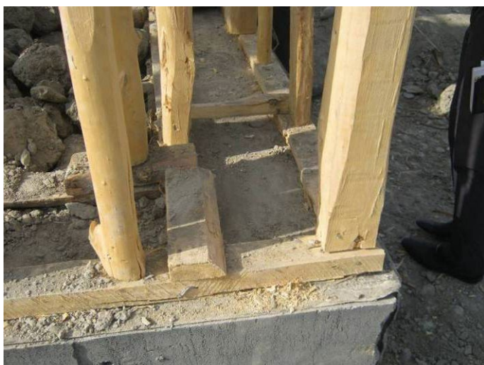
Рис. 5 Общие виды смоделированных систем по вариантам задачи: а) при исследовании необходимости устройства анкерных связей для соединения нижних обвязочных брусов синчевых каркасов с фундаментами; б) при исследовании решения синчевого каркаса с использованием в его верхней части шарнирно-подвижной стоечно-балочной системы
