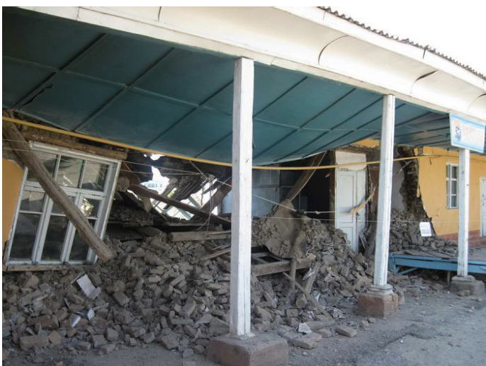
Рис. 1 Последствия землетрясения 20.07.2011 г. (на границе Узбекистана и Киргизии); I = 6,5-7,0 ; M = 6,1-6,2 Figure. 1 Consequences of the earthquake of 20.07.2011 (on the border of Uzbekistan and Kyrgyzstan); I = 6.5-7.0 ; M = 6.1-6.2
