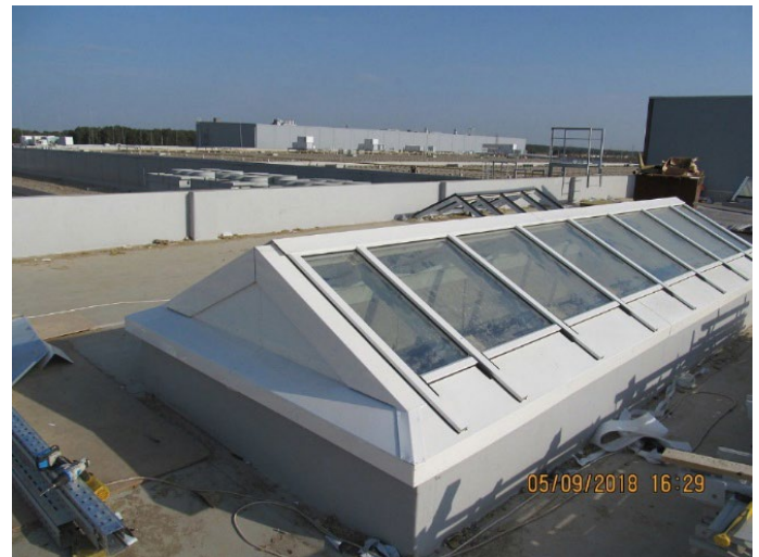
Рисунок 8. ПОСЛЕ монтажа двускатных зенитных фонарей
