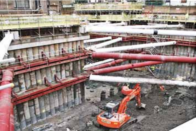
Рис. 1. Возведение монолитного здания способом «снизу вверх» Fig. 1. Construction of a monolithic building using the «bottom-up» method
