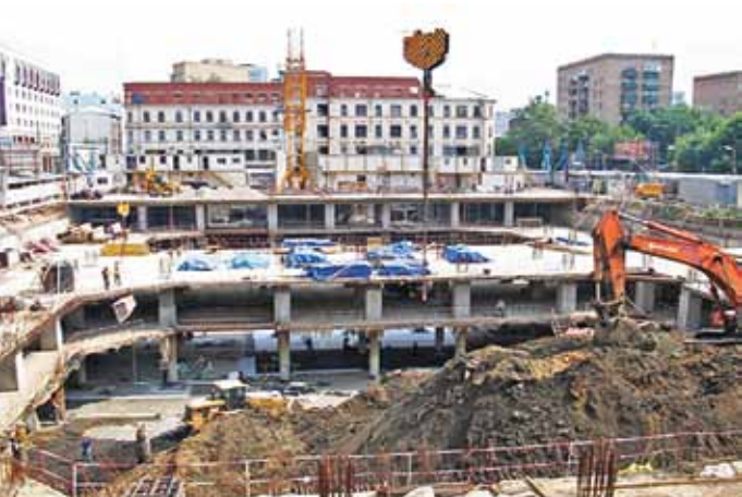
Рис. 2. Строительство проекта жилого комплекса «Четыре Ветра» полужакрытым способом в Москве Fig. 1. The construction of the residential complex «Chetyre Vetra» by a semi-closed method in Moscow
