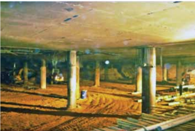
Рис. 4. Разработка грунта в котловане проекта «Lotte hotel Moscow» закрытым способом в Москве Fig. 4. Excavation works in «Lotte hotel Moscow» by a closed method in Moscow
