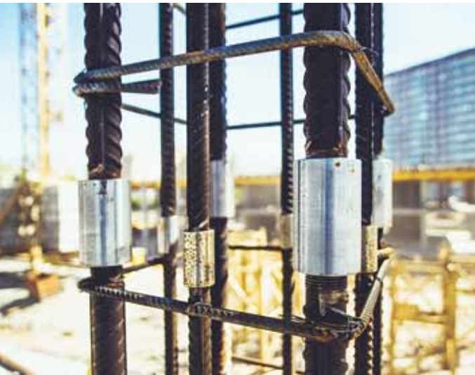
Рис. 4. Соединение арматур с помощью муфт Fig. 4. Connection of fittings with couplings
