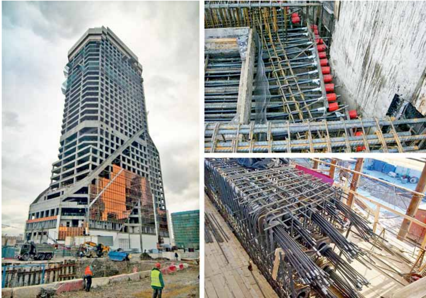
Рис. 3. Использование технологии преднапряжённого железобетона при строительстве башни Меркурий комплекса «Москва-Сити» Fig. 3. Using the technology of overstressed reinforced concrete in the construction of the Mercury tower of the Moscow City complex
