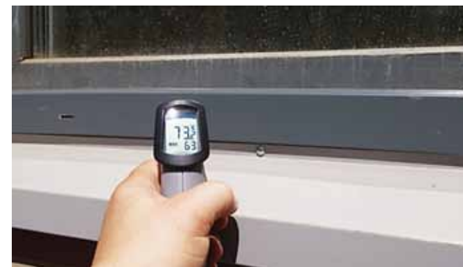
Рис. 3. Замер температуры профилей оконного блока Fig. 3. Temperature measurement of window block profiles
