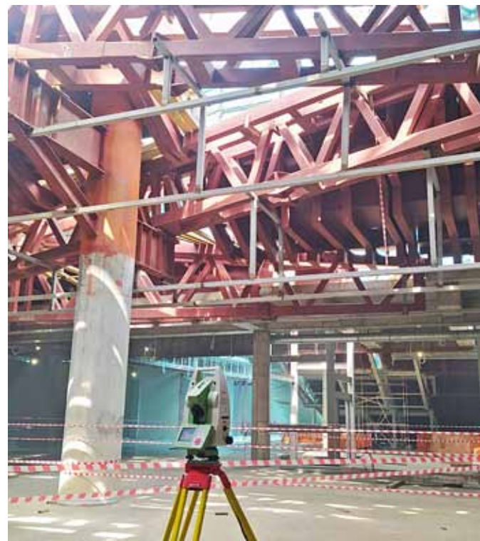
Фото 5. Процесс работы по контролю за совмещением элементов поясов ферм верхнего и нижнего ярусов. Геодезические измерения также выполняются электронным тахеометром Leica TS11
