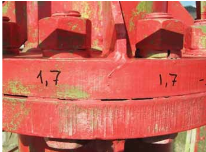
Рис. 5. Зазор 1,7 мм между фланцами пояса А на отметке 36 м Fig. 5. Gap of 1,7 mm between flanges (girth A, height of 36 m)
