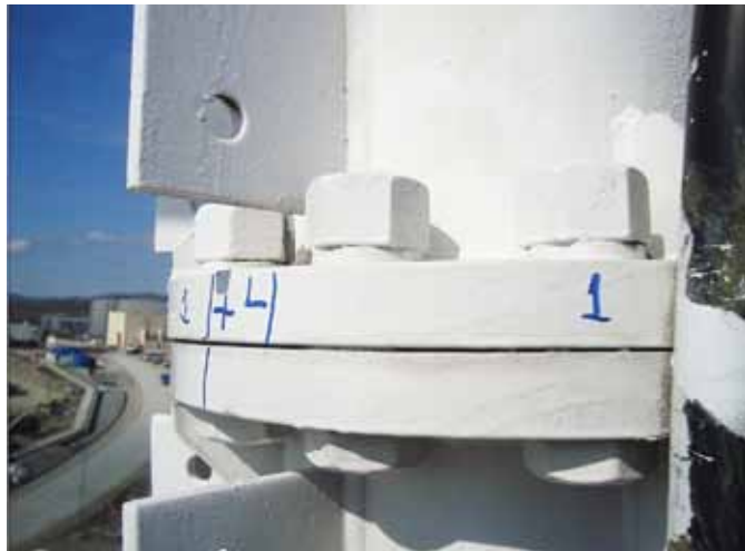
Рис. 6. Относительное радиальное смещение фланцев пояса С на 4 мм на отметке 24 м Fig. 6. Relative radial displacement of girth's C flanges of 4 mm at a height of 24 m
