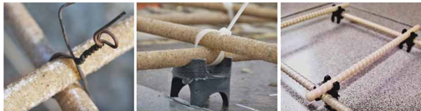
Рис. 3. Соединение стержней: а) стальной вязальной проволокой; б) пластиковыми хомутами-стяжками; в) фиксаторами-клипсами (источник: https://www.enrost.ru/ )
