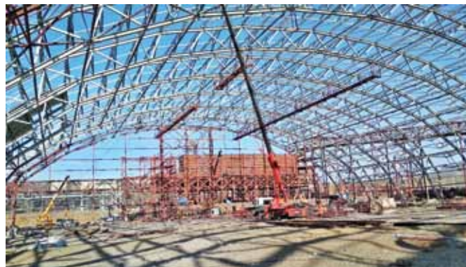
Рис. 2. Апробация на практике предложенной технологии при монтаже склада усреднения ЖРС Fig. 2. Approbation in practice of the new technology model during the installation of the iron ore blending warehouse
