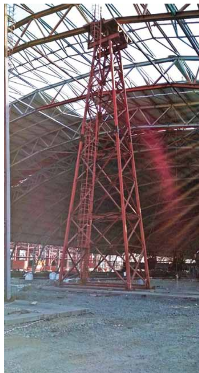
Рис. 3. Монтаж временных опор Fig. 3. Installation of temporary supports
