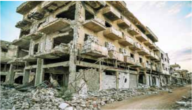
Рис. 7. Здание 2-й группы повреждений Fig. 7. Building of the second group of damage
