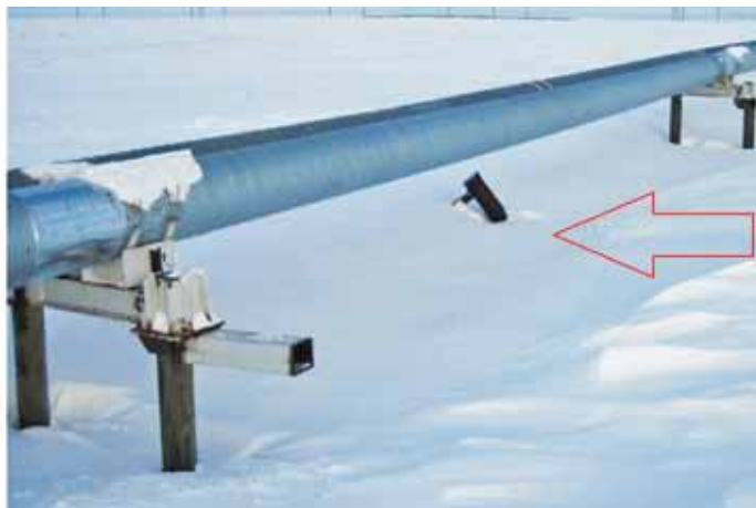
Рис. 5. Выдёргивание фундамента и полное изъятие свай из грунтов основания вследствие действия касательных сил морозного пучения
