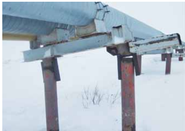
Рис. 5. Выдёргивание фундамента и полное изъятие свай из грунтов основания вследствие действия касательных сил морозного пучения
