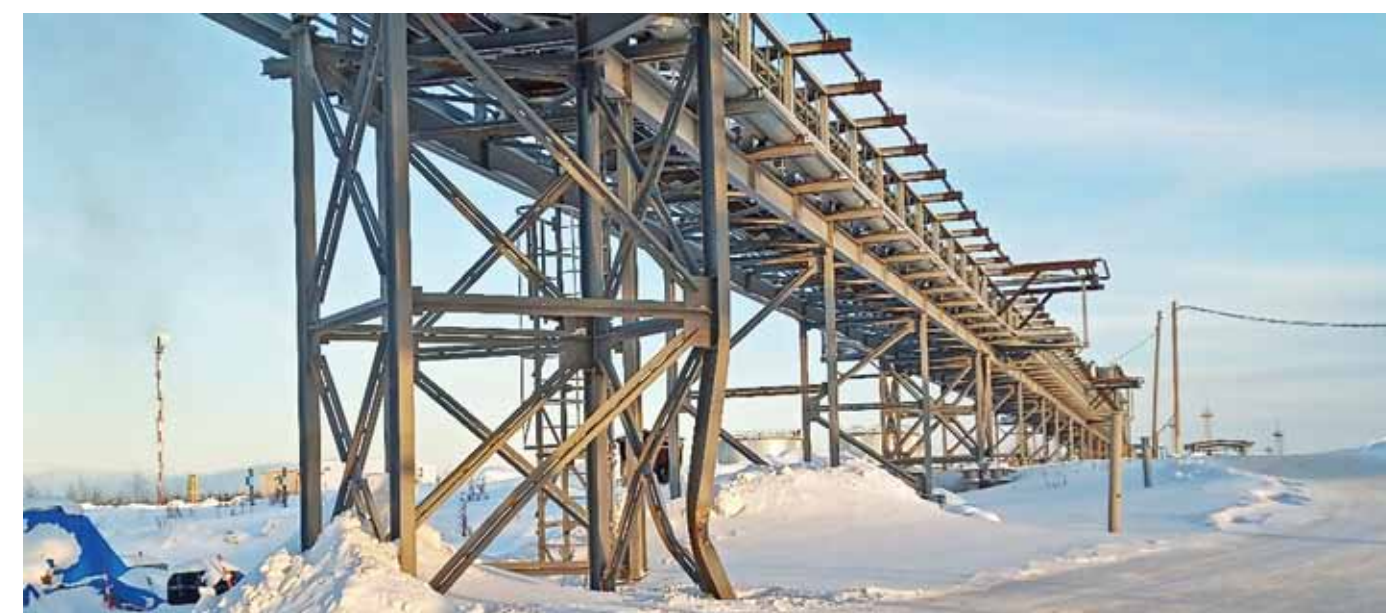
Рис. 14. Деформации пояса и элементов решётки опоры вследствие механического воздействия – наезда автотранспортного средства
