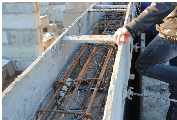
Рис. 2. Бетонирование фундаментной плиты в зимних условиях.
