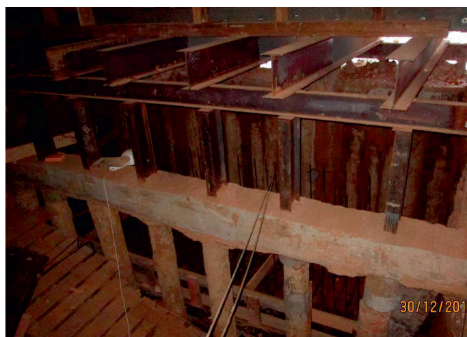
Рис. 1. Процесс вывешивания стен здания на временные фундаменты
