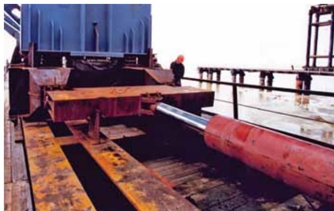
Рисунок 1. «Надвижка» домкратами, установленными в торце конструкции.
