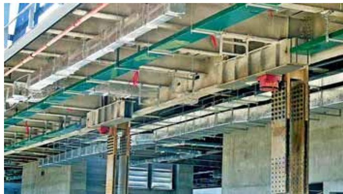
Рисунок 4. Конструктивный элемент здания Figure 4. Constructive element
