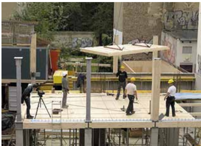
Рисунок 2 Использование CLT-панелей в качестве плит перекрытий Figure 2 Using CLT panels for floor slabs
