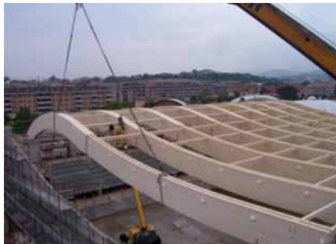
Рисунок 3 Монтаж большепролетной балки из LVL-бруса Figure 3 Montage of a large-span LVL beam
