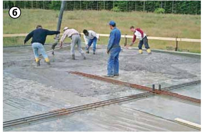
**Рис. 4.** А) фибробетонная смесь, В) возведение прототипа
