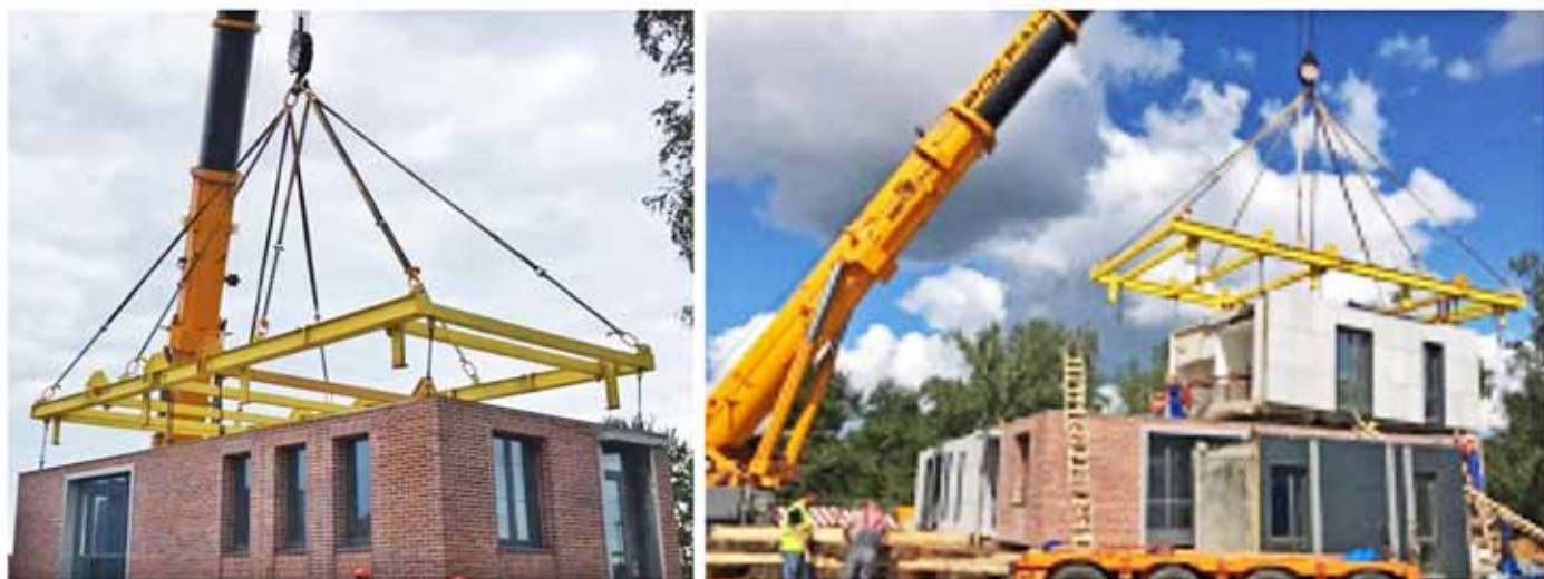
Рис. 5. Монтаж крупногабаритного объемного блока
