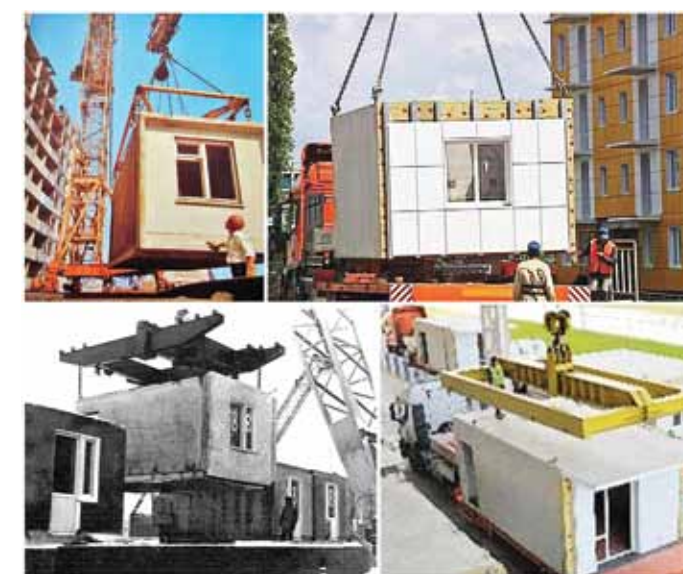
Рис. 3. Организация захвата модульного блока (блок-комнаты) в железобетонном исполнении Fig. 3. Organization of module block (block-room) gripping made of reinforced concrete
