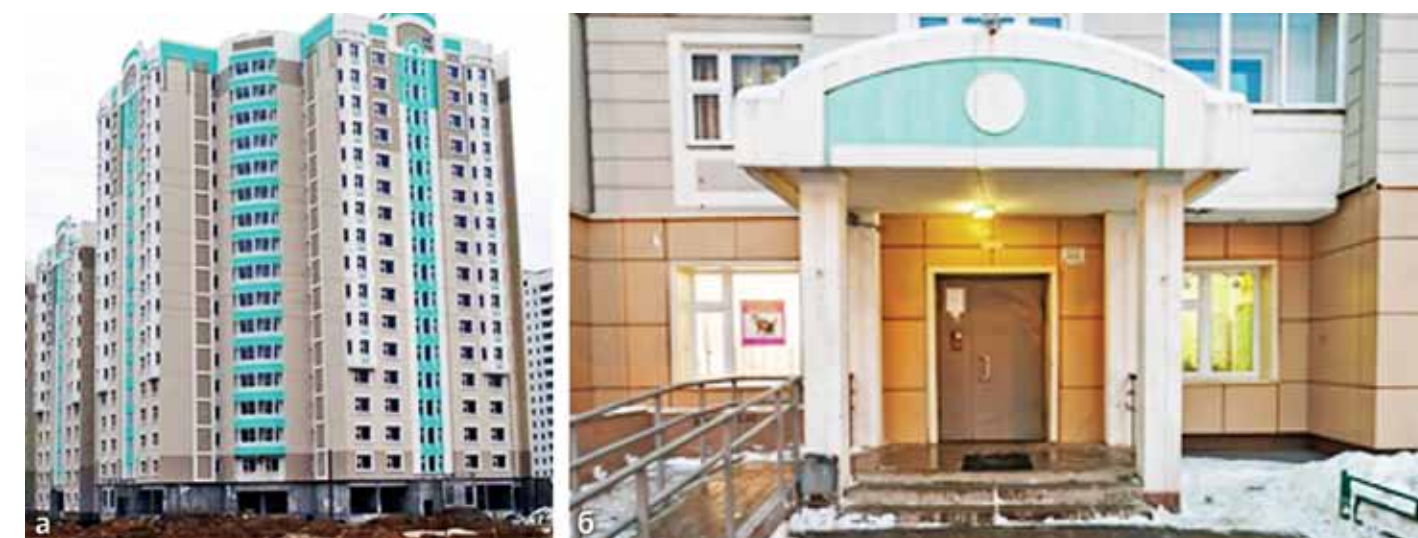
Рис. 1. Многоэтажный дом серии П-3М-7/23: а) общий вид; б) вход в здание Fig. 1. Multi-storey house of P-3M-7/23 series: a) overview; b) entrance to the building
