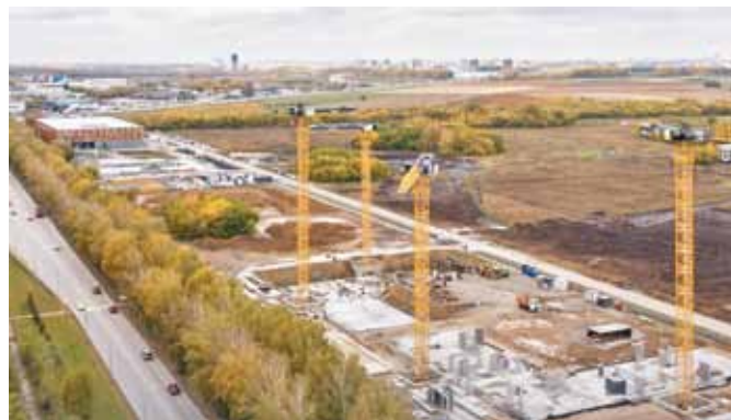
Рис. 1. Общий вид строительной площадки проекта «Пшеница» ДК «Брусника» с временным заводом сборных железобетонных элементов на заднем плане
