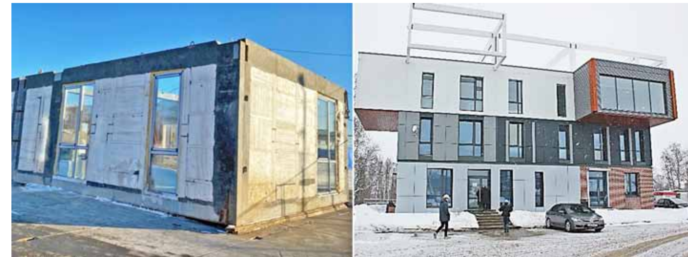
Рис. 3. Сборка блок-квартиры и опытная сборка жилой секции из блок-квартир на строительной площадке ГК «МонАрх»
