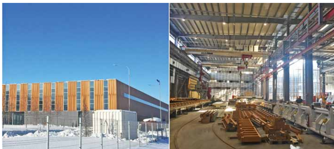
Рис. 2. Сборно-разборный завод на строительной площадке проекта «Пшеница». Общий вид и основной производственный пролет
