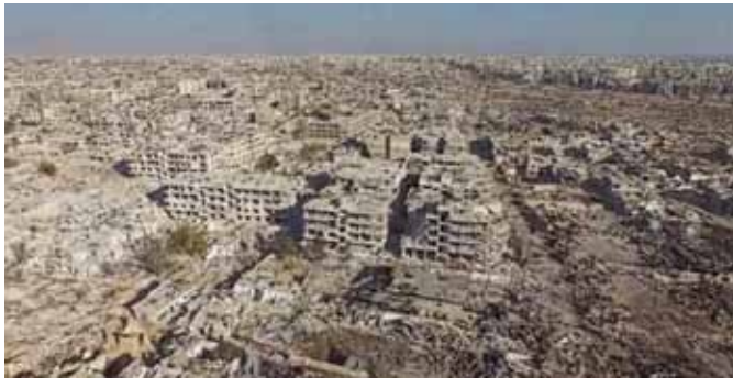
Рис. 2. Разрушение в г.Дамаск в Сирии Fig. 2. Destruction in Damascus, Syria
