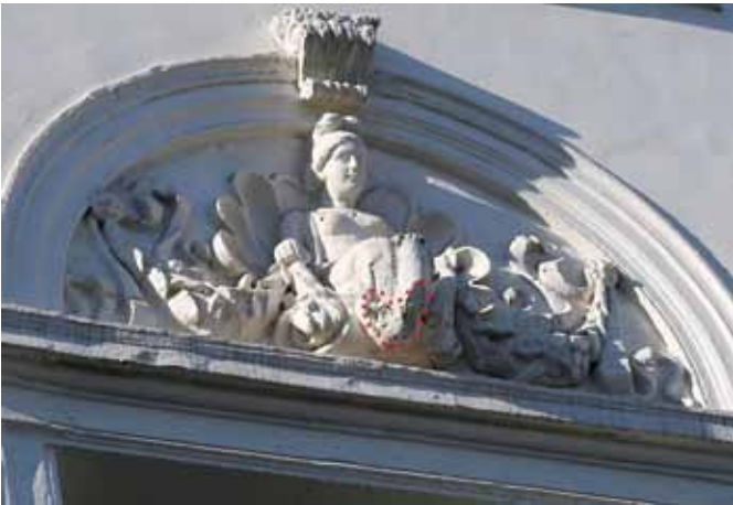
Рис. 1. Выбор полностью разрушенного элемента при помощи множества точек Fig. 1. Selection of a completely destroyed element by a set of points
