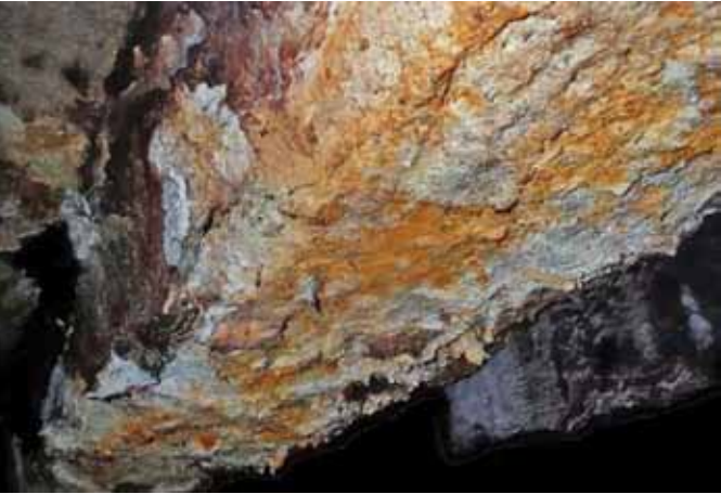
Рис. 1. Типичные разрушения бетона защитного слоя железобетонных конструкций Fig. 1. Typical concrete destruction of the protective layer of reinforced concrete structures
