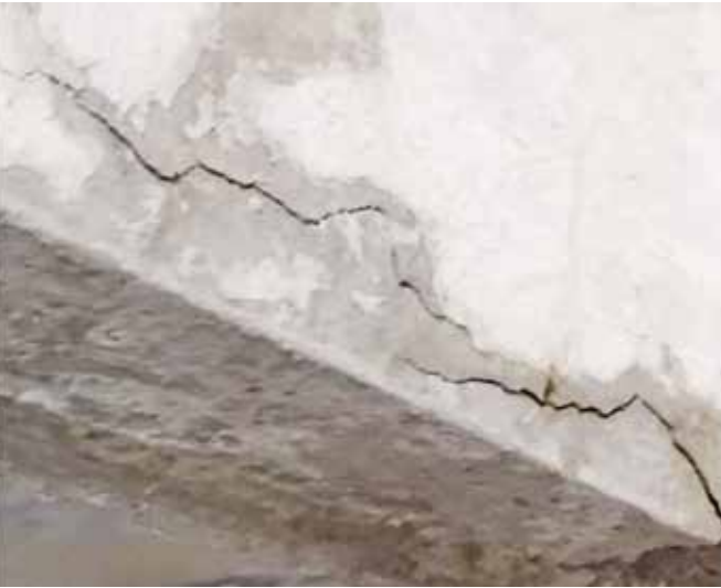
Рис 3. Появление трещин в зоне восстановления конструкции Fig. 3. The appearance of cracks in the area of restoration of the structure
