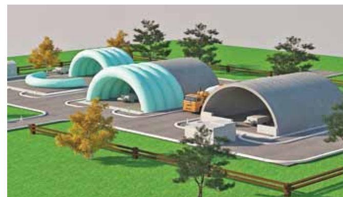
Рис. 3. Визуализация запатентованной технологии возведения сводов на пневмоопалубке
