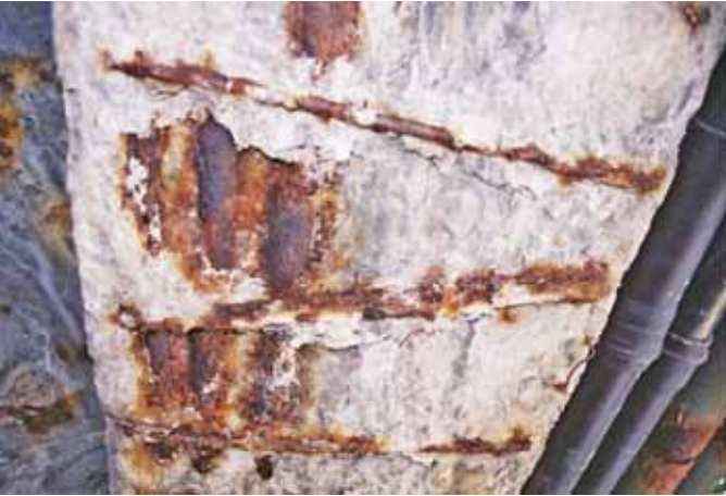
Рис. 1. Типичные разрушения бетона защитного слоя железобетонных конструкций Fig. 1. Typical concrete destruction of the protective layer of reinforced concrete structures
