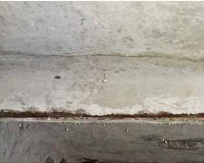
Рис 3. Появление трещин в зоне восстановления конструкции Fig. 3. The appearance of cracks in the area of restoration of the structure
