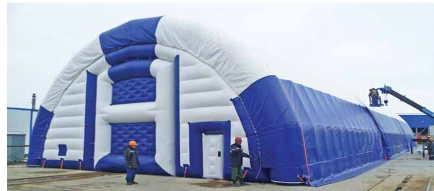
Рис. 5. Пневматическое сооружение компании РОСАНАР Fig. 5. Pneumatic construction of the ROSANGAR company
