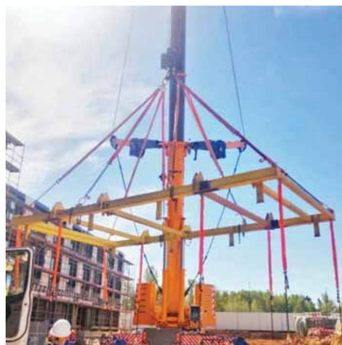
Рис. 3. Общий вид траверсы, применяемой на сегодняшний день при возведении зданий из крупногабаритных модулей по инновационной технологии, разработанной ООО «Комбинат Инновационных Технологий – МонАрх»
