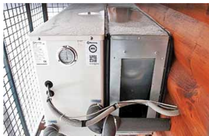
Рис. 1. Фото камеры смешения, совмещенной с БТН [14], установленной в малоэтажном жилом здании в Ивановской области
