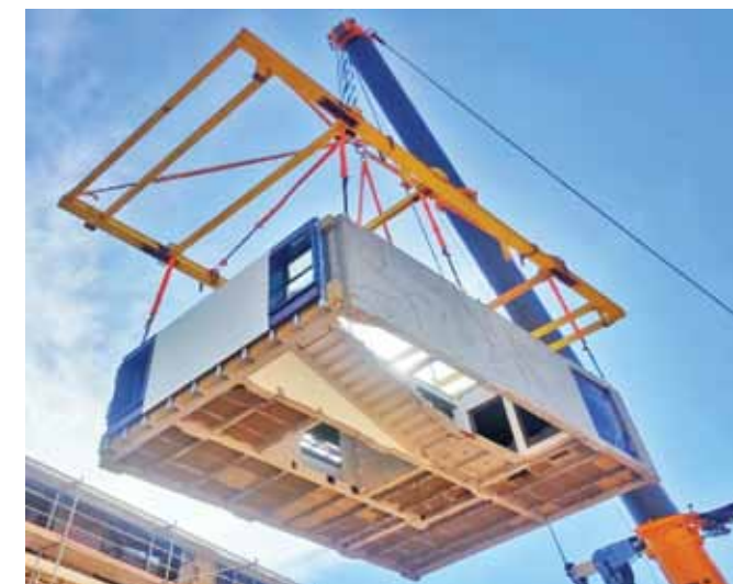
Рис. 4. Траверса с подвешенным к ней модулем в процессе проведения монтажных работ Fig. 4. A traverse with a module suspended from it during installation work
