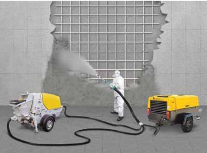
Рис. 1. Нанесение торкрет-бетона Fig. 1. Application of shotcrete concrete
