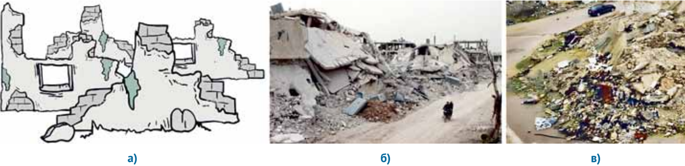
Рис. 1. Вид полностью разрушенных зданий в результате боевых действий в Сирии: а) оцифрованное изображение малоэтажного здания из глины [16]; б) фото малоэтажного здания из натурального камня (базальта) [17]; в) фото остатков многоэтажного здания из монолитного железобетона [18] Fig. 1. View of completely destroyed buildings as a result of hostilities in Syria: а) Digital image of a low-rise clay building [16]; б) photo of a low-rise building made of natural stone (basalt) [17]; в) photo of the remains of a multi-storey building made of monolithic reinforced concrete [18]
