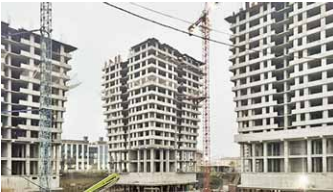
Рис. 1. Многоэтажные монолитные дома по ул. А. Митаева в г. Грозный
