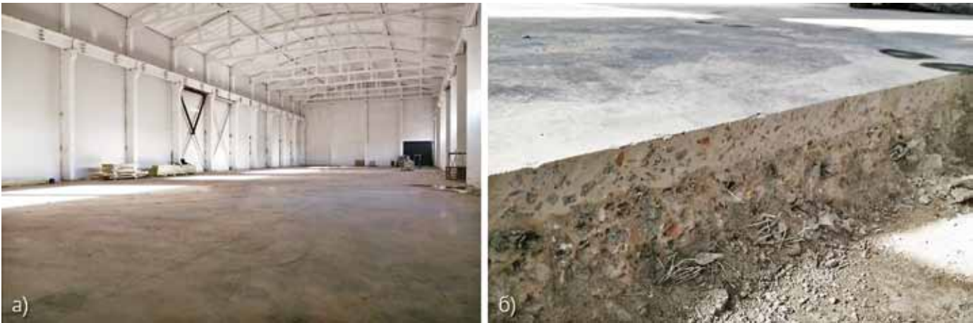
Рис. 4. Внешний вид: а) производственного цеха после выполнения работ, б) фрагмента пола Fig. 4. Appearance of: a) the production workshop after the work has been completed, b) a fragment of the floor
