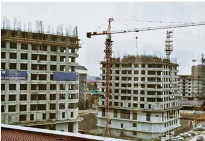
Рис. 2. Строительство жилого дома в центре г. Грозный с использованием крупнощитовой опалубки
