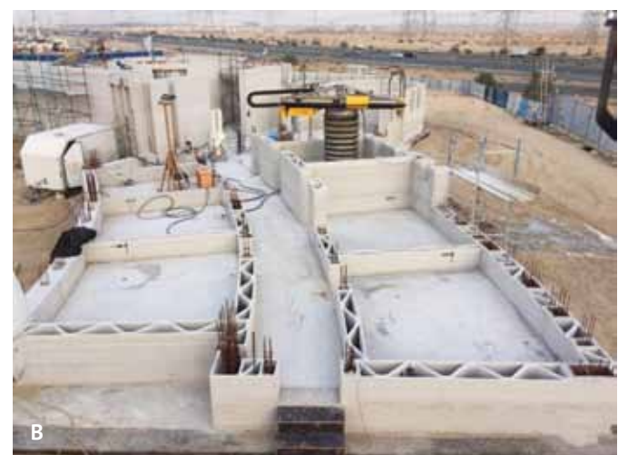
Рис. 1. Типы строительных 3D-принтеров: а) порталный принтер, б) принтер типа «дельта», в) роботизированный принтер
