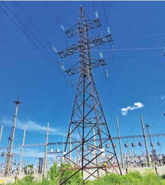
Рис. 1. Рассматриваемая опора ВЛ марки У110-4+5 Fig. 1. A considered support U110-4+5 OHL
