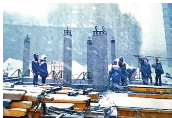
Рис. 1. Производство первых крупногабаритных объёмных блоков в полигонных условиях Fig. 1. Production of the first large-sized volumetric blocks in ground conditions
