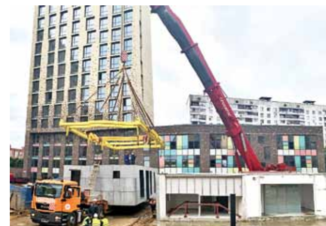
Рис. 2. Демонтаж здания из крупногабаритных объёмных блоков Fig. 2. Building of large-sized volumetric blocks dismantling
